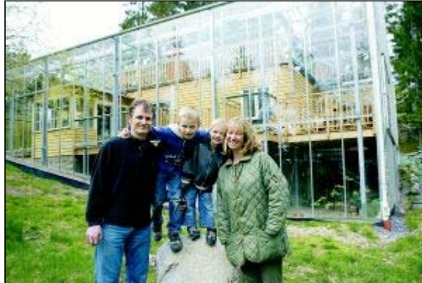
NY INNEBÖRD. Det ser lite märkligt ut, men för familjen Sacilotto har ordet växthuseffekt kanske en annan innebörd. Deras hus står inuti ett växthus, vilket ger en energisparande effekt. Foto: MAJA SUSLIN/Scanpix
