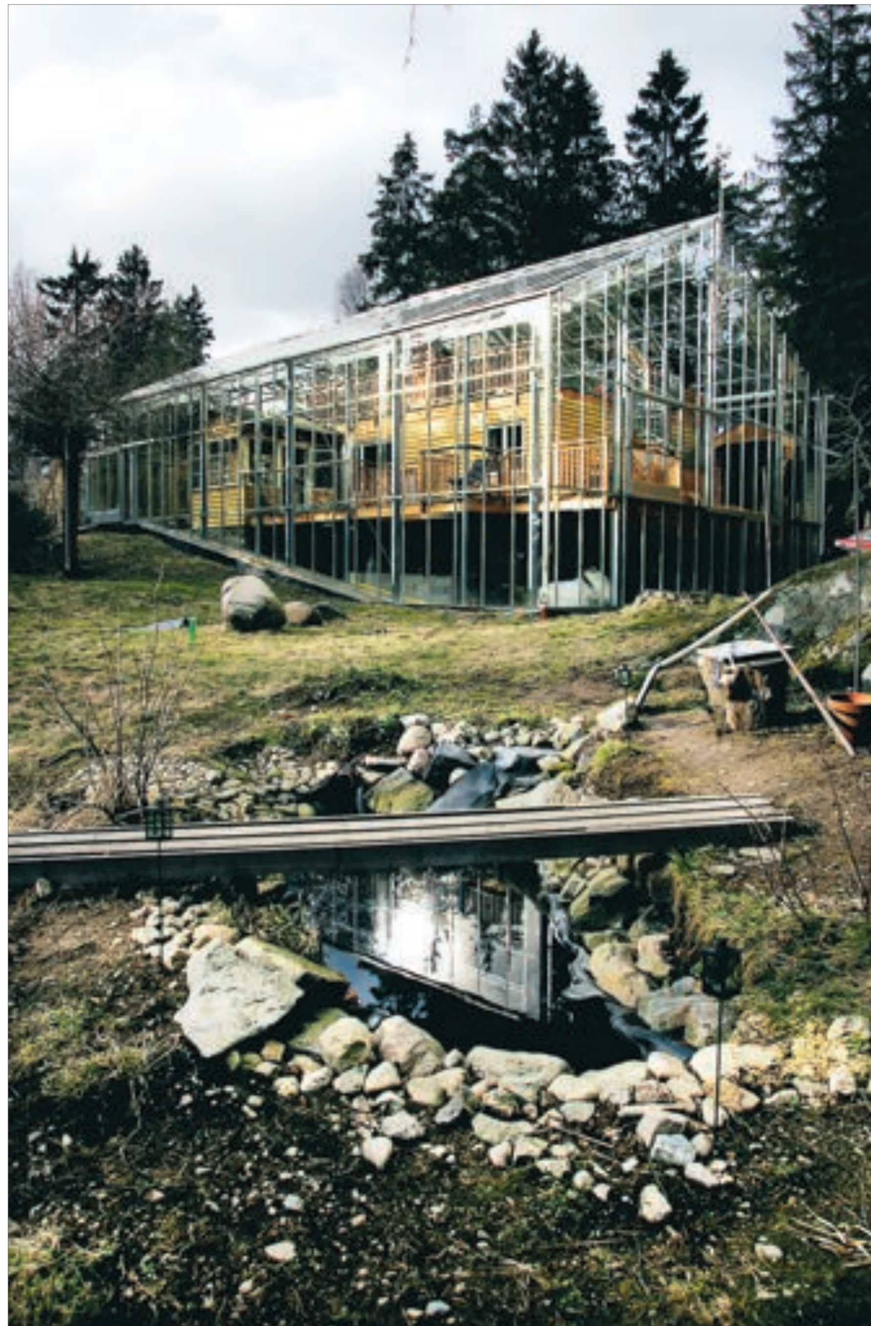
Avloppsvattnet leds vidare ut till en damm. Här finns några glupska guldfiskar som väntar på att ta hand om det sista av näringen.
